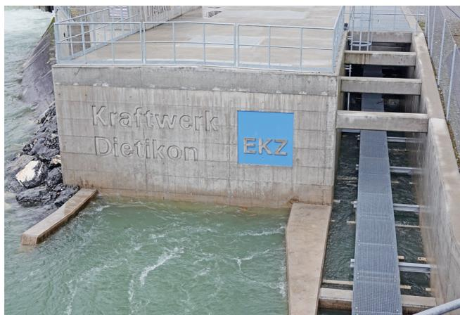
**Abbildung 4:** Dotierkraftwerk KW Dietikon mit Multi-Struktur-Schlitzpass und Wartungssteg, Limmat, © Eva Baier, Fischwanderung.ch GmbH
