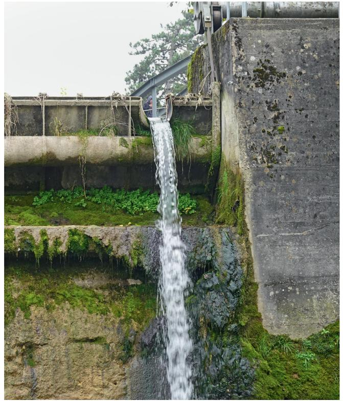
**Abbildung 8:** Unglücklicher Versuch eines Fischabstiegs: keine Leitströmung zur Öffnung im Wehrfeld und grosse Verletzungsgefahr durch Aufprall auf dem Wehrsockel, © Eva Baier, Fischwanderung.ch GmbH
