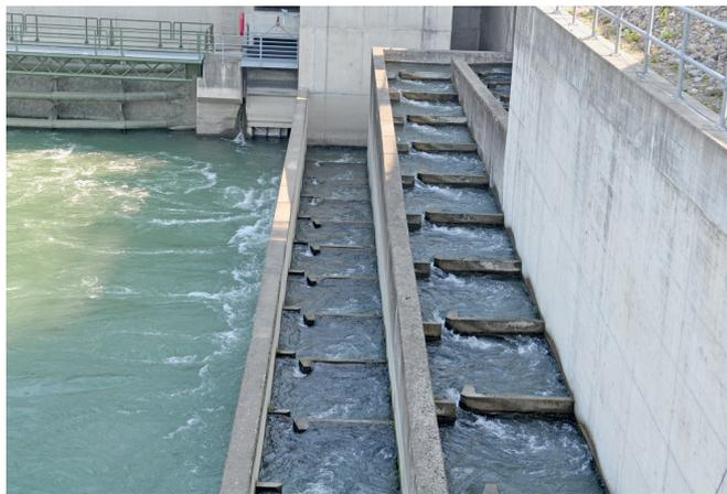
**Abbildung 2:** Klassischer Vertical Slot Fischpass am Kraftwerk Rheinfelden, Rhein, © Eva Baier, Fischwanderung.ch GmbH
