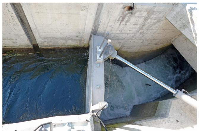
**Abbildung 7:** Stemmtor einer Fischabstiegseinrichtung am Kraftwerk Dietikon, Limmat, © Eva Baier, Fischwanderung.ch GmbH
