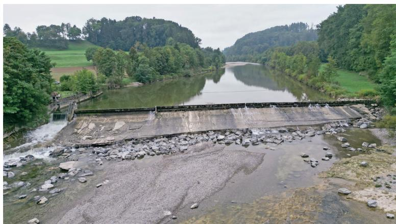
**Abbildung 1:** Stauwehr eines zu sanierenden Kraftwerks an der Thur, welches aktuell nicht fischgängig ist. © Eva Baier, Fischwanderung.ch GmbH
