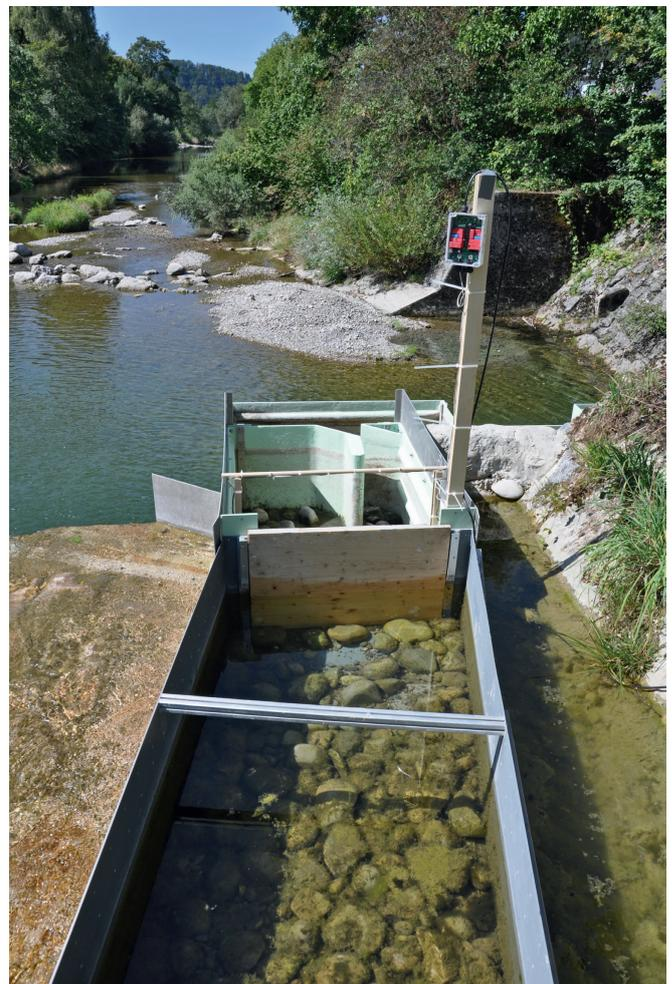
**Abbildung 10:** PIT-Tag-Installation an einer Fischaufstiegshilfe für eine biologische Wirkungskontrolle, © Eva Baier, Fischwanderung.ch GmbH
